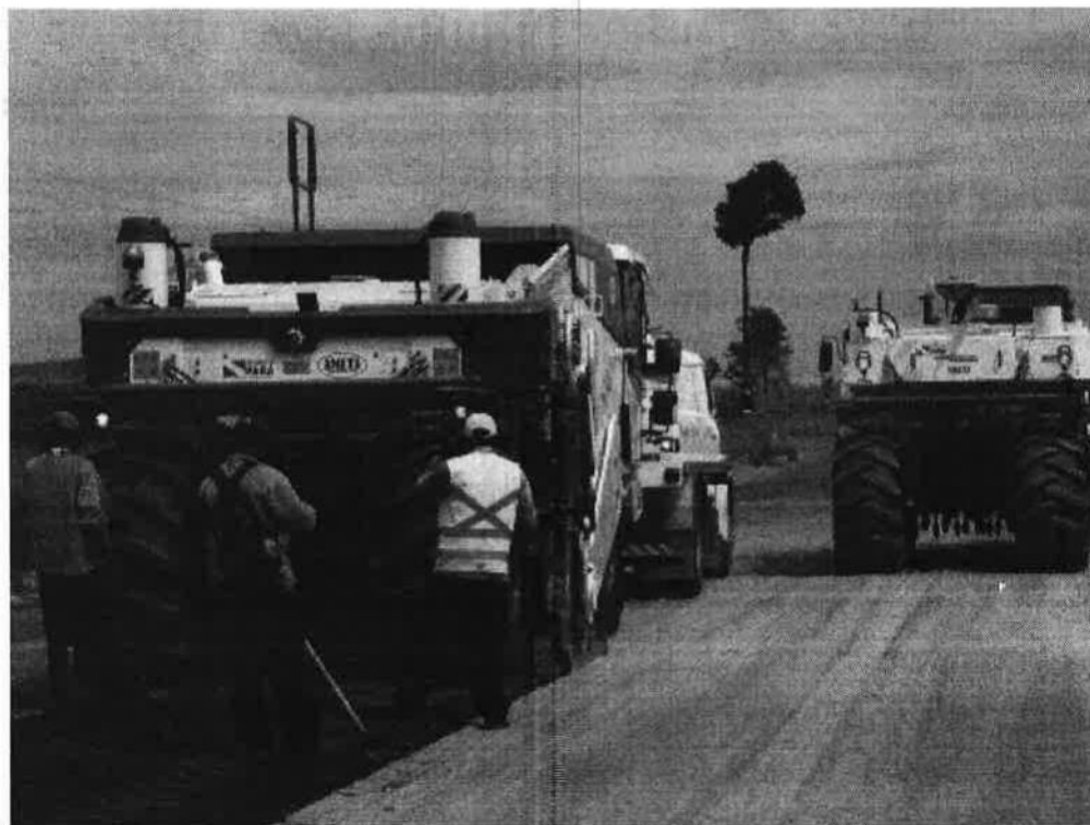
Foto Ilustrativa: Restauração da Rodovia PA-150, Marabá-PA
